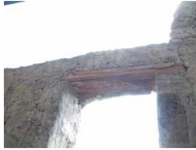
Finestra del piano primo verso ovest. Si vede l'allargamento di questa verso sinistra.
