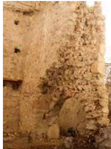
Edificio est interno. Si vede il nucleo della muratura.
