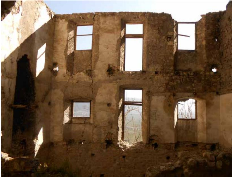
Grandi aperture nel prospetto sud dell'eremo.
