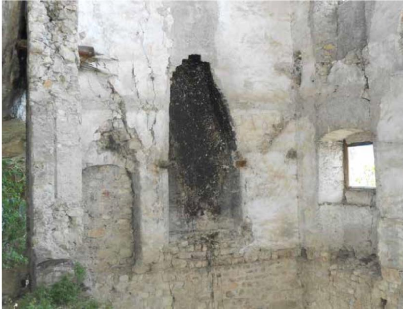
Prospetto est interno dell'eremo. Mancanza della cappa del camino, colature sulla muratura e lesioni supra la porta tamponata.
