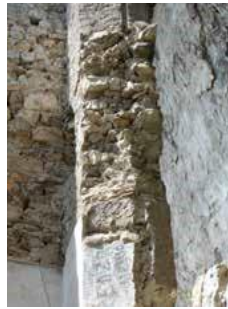
Finestra sul prospetto sud al piano terra. Finestra al primo piano prospetto ovest. Profili di aperture sul prospetto nord.
