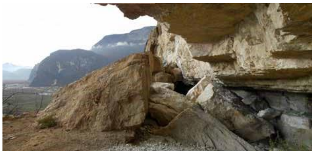
Resti di muro parzialmente schiacciati dai massi nella parte più occidentale della caverna.
