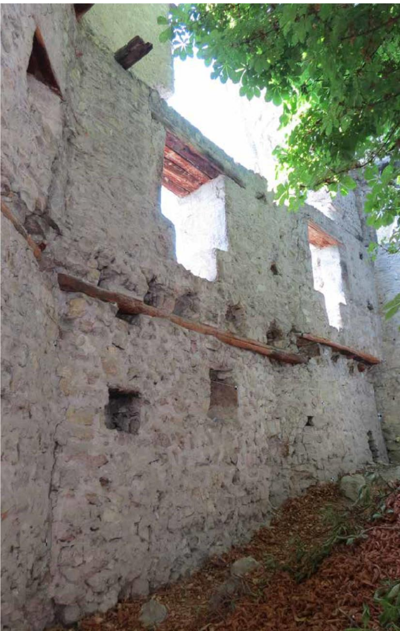
Edificio est, interno parete sud.
