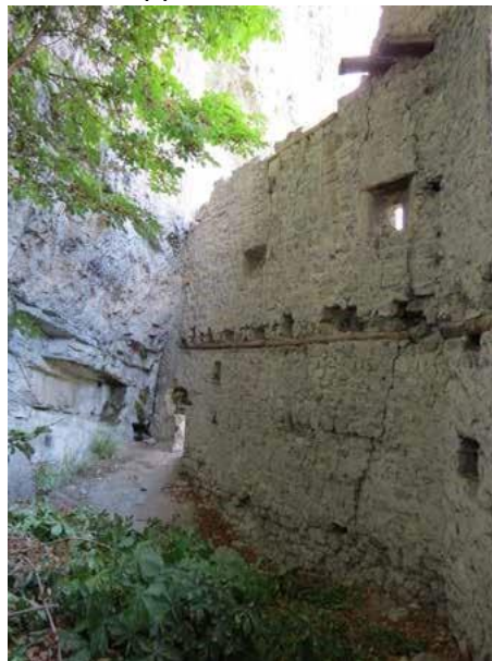
Parete interna sud-est.
