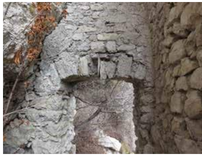
Ingresso e particolare dell'arco ribassato con assi in legno.
